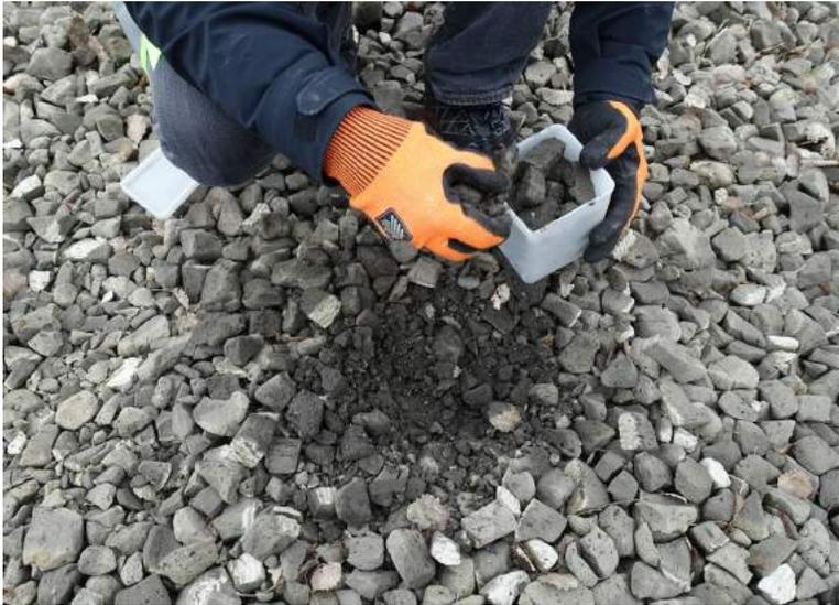
Schaumglasschotter-Schüttung als Wärmedämmung
